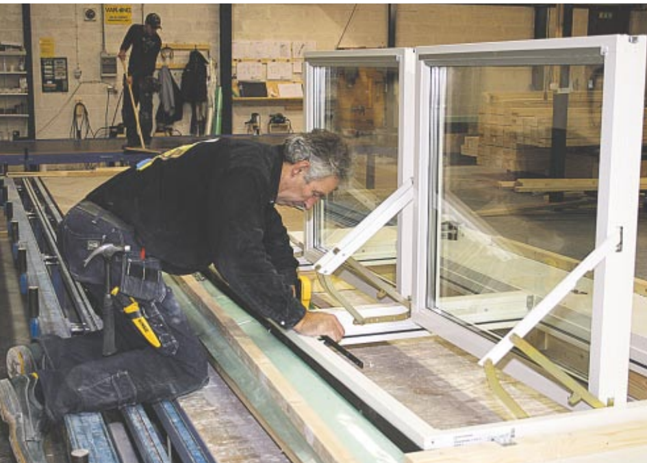
I det nya såghuset tillverkas färdiga väggelement. Inge Jönsson monterar här in fönster.
